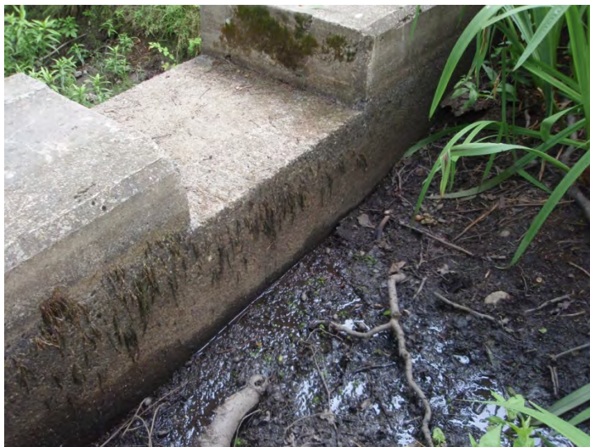
Bild 2. Uttorkat dämme från dammsidan 2014-06-27
