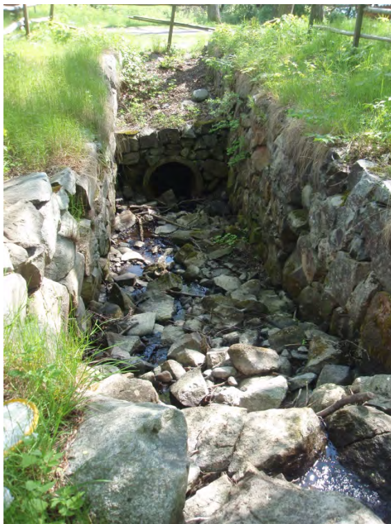
Bild 3. Kvarnhjulsrännan sydost om dammen där två stycken 60 cm breda kvarnhjul med en diameter av 7,2 meter drevs av vatten från dammen. 2014-05-23.
