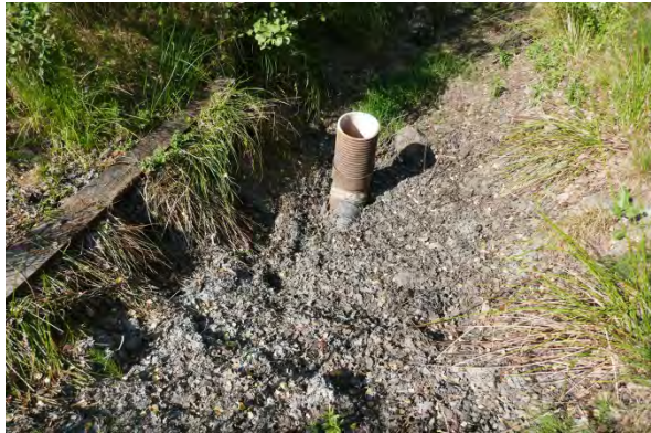
Dike nedom dämme helt torrt 2018-07-18.
