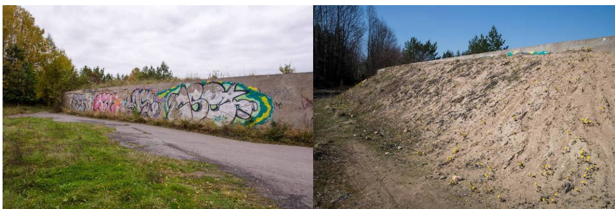
Cementvägg före åtgärd och cementvägg med sandvall.
