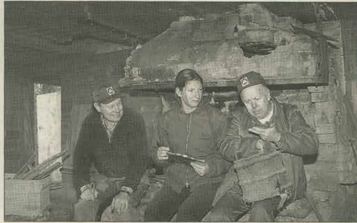
MÅSTE LAGAS. Vad gör vi åt smedjans mur? Rune Rubensson, Mimmi Gollas och Ove Jansson skissar några av åtgärderna.
