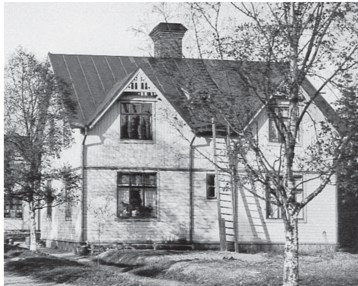
Arbetarbostad från söder
