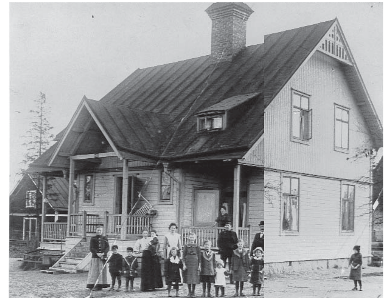
Arbetarbostad från norr
