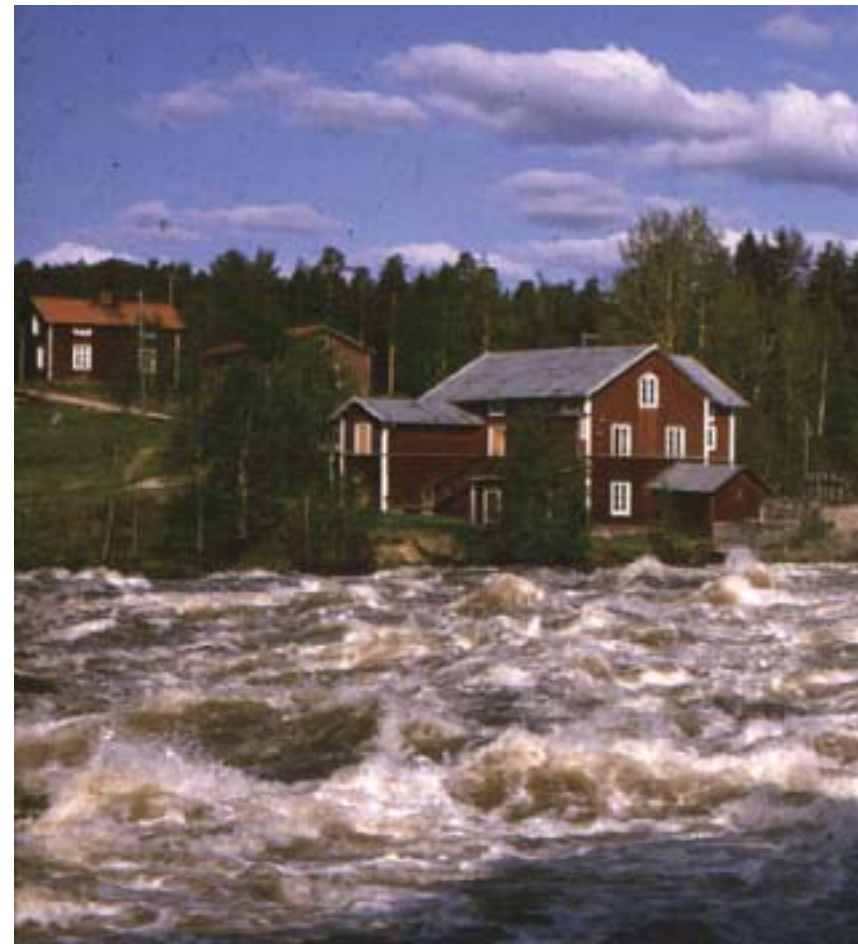
Utsikt mot kvarnen från andra sidan älven. I bakgrunden ses mjölnarbostaden.
